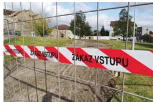
Prostor v Mezibraní se změnil v dočasné staveniště, Foto: Radim Tuček
