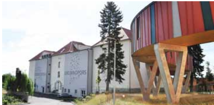
Hlavní budova literárního archivu (vlevo) je s oddělením uměleckých sbírek a knihovnou propojena tunelem.
